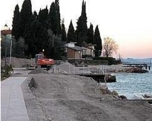
Lungolago a castelletto dopo i lavori del 2006
