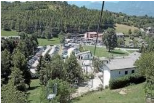
La partenza dell'impianto di Costabella a Prada
